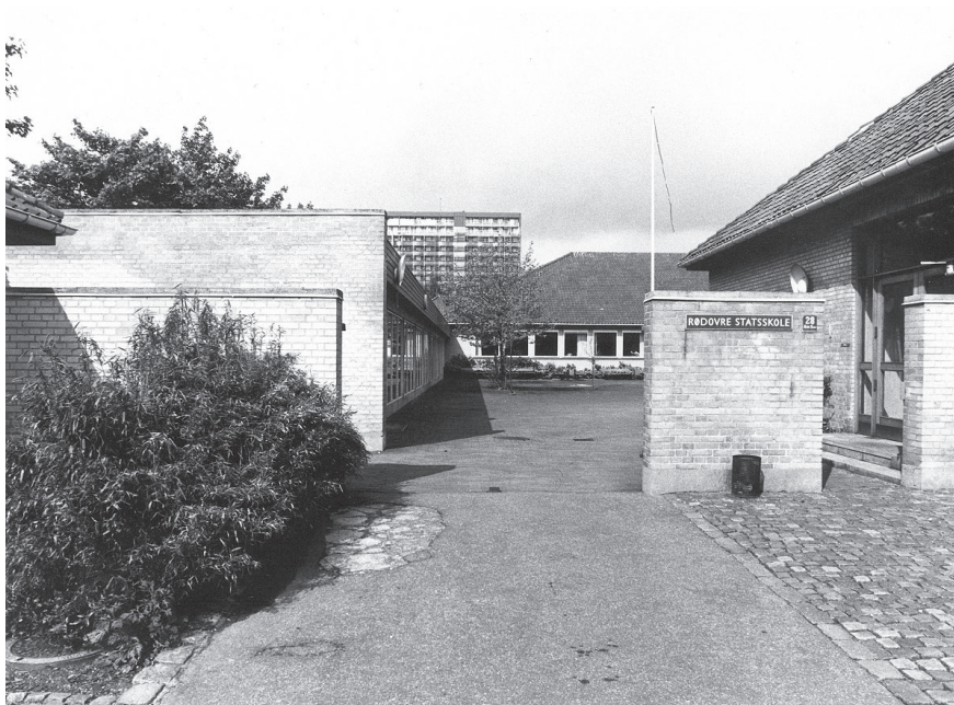
Rødovre Statsskole blev i 1958 Vestegnens første gymnasium. Den blev – som Virum Statsskole – udformet som et lavere 1-2 etagers bygningskompleks i modsætning til de fleretagers nybygninger til Frederiksborg Statsskole og Nykøbing Katedralskole (foto cirka 1970, Rødovre Kommunes Lokalhistoriske Samling).
